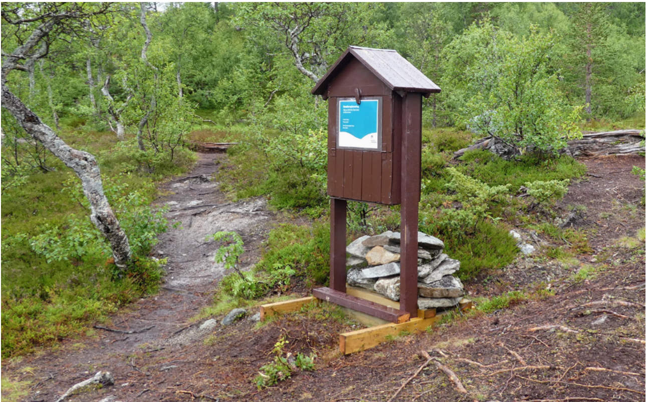
Kasse med steinfundamentering, Børgefjell 2017. Foto: Tore Tødas
