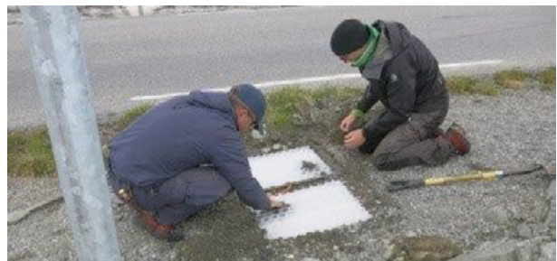
Montering av mattesensor
